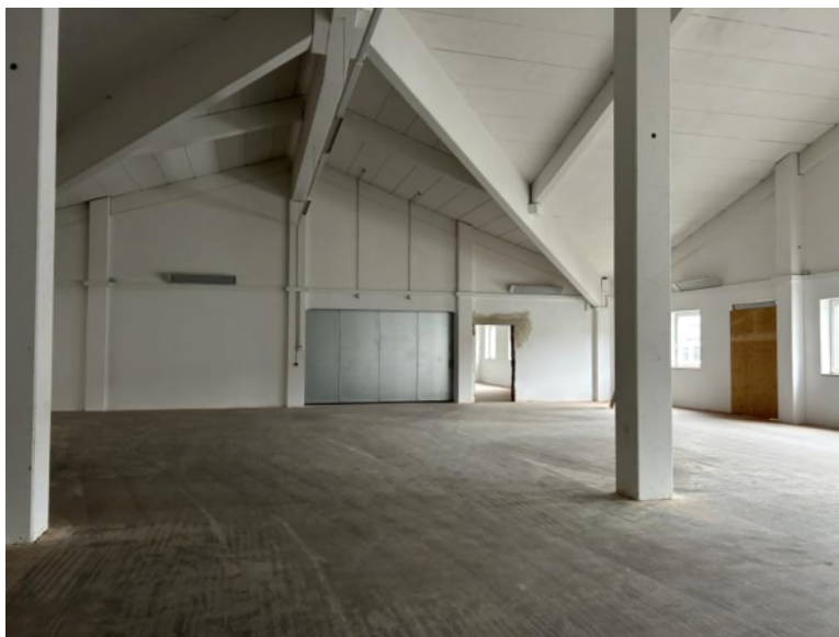
Abbildung 1. Innenausbau im Obergeschoss.
