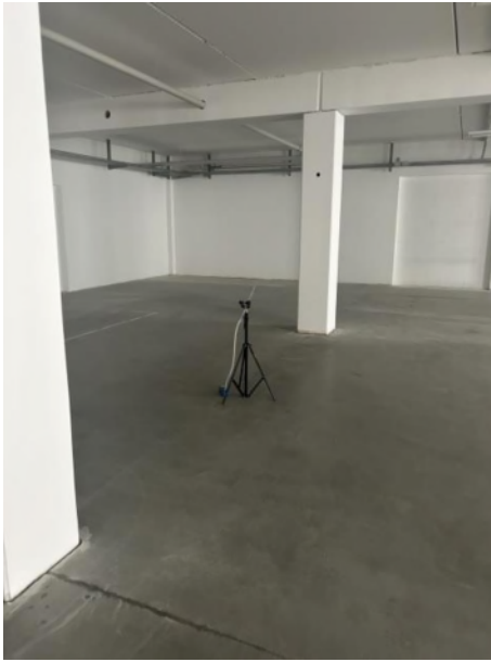
Abbildung 4. Raumlufthabnahme im Raum ME 4, EG.
