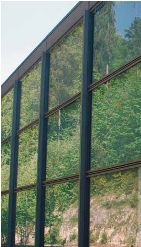
An Sonnenschutzgläsern bildet sich aufgrund des hohen Reflexionsgrades die Umgebung realitätsnah ab. Hier eine Turnhalle, bei der eine Front parallel zu einem Waldrand verläuft. Für Gläser mit einem hohen Reflexionsgrad gibt es bei dieser westwärts exponierten Seite keinen zwingenden Grund.
