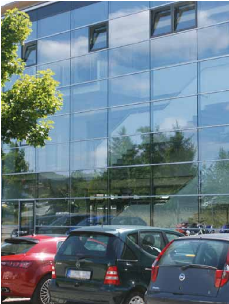
Stark spiegelnde Glasfront eines Schulhauses.
