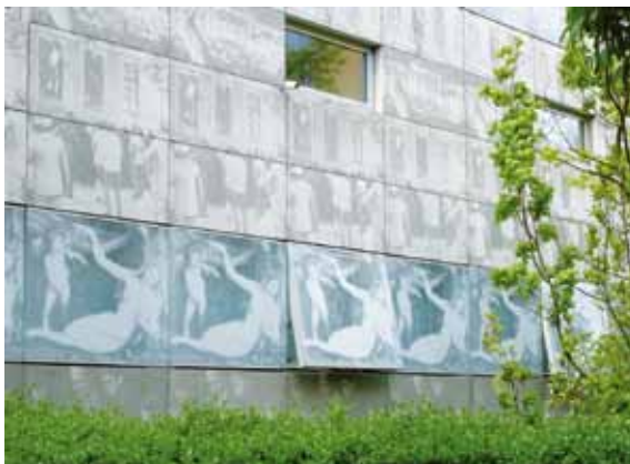
Hochschule für nachhaltige Entwicklung Eberswalde (HNE) mit flächig bedruckten Fenstern und Fassadenteilen.
