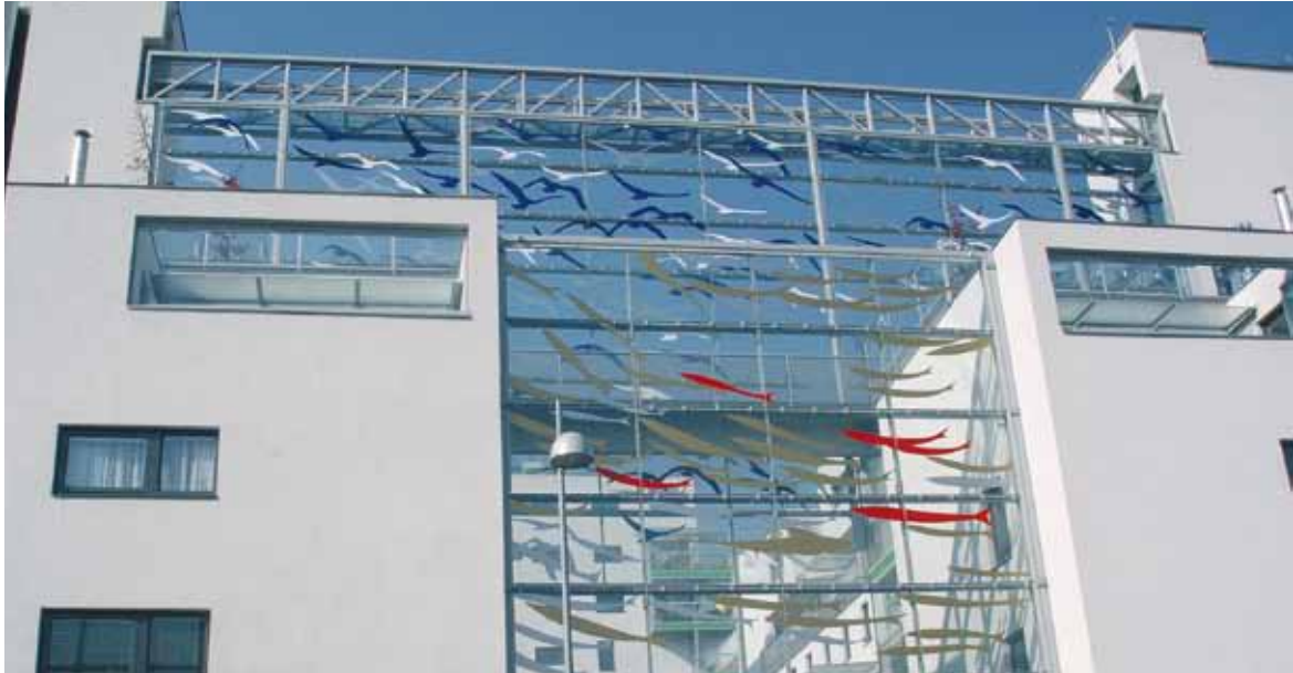
Oben: Wenn eine großflächige Glaswand unverzichtbar ist: Warum nicht gleich eine interessante, bisher nie gesehene Lösung wählen? Optimal ist das Beispiel allerdings nicht, denn es bleiben stellenweise zu große Lücken offen.
