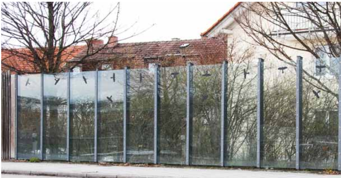
Die gläserne Lärmschutzwand vor den Büschen ist für anfliegende Vögel nicht zu erkennen. Die Greifvogelsilhouetten bestätigen, dass das Problem wahrgenommen wurde. Lösen werden sie es hingegen nicht.
