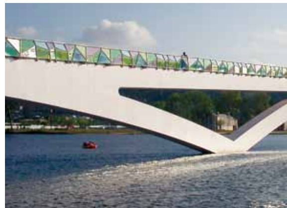
Diese Fußgängerbrücke in Coimbra/Portugal bringt Farbe in die Landschaft.
