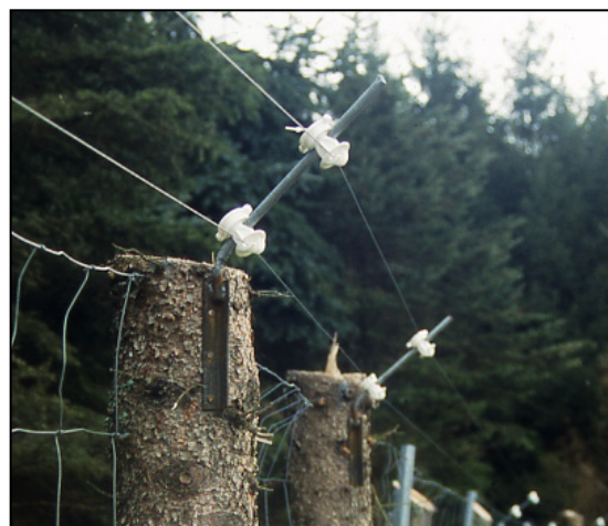
Abbildung 24: Nachträgliche Elektrifizierung eines Gehegezaunes.
