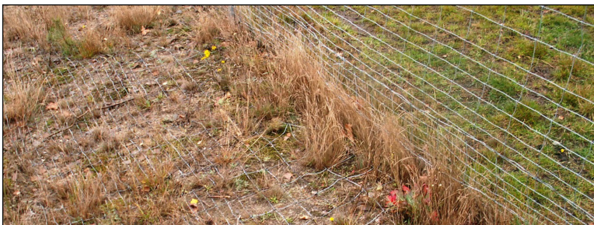
Abbildung 25: Das Anbringen einer Zaunschürze verhindert das Untergraben von nichtelektrifizierten Zäunen. Sen sich diese jedoch als kostengünstige und schnelle Schutzmöglichkeit ebenfalls verbauen.
